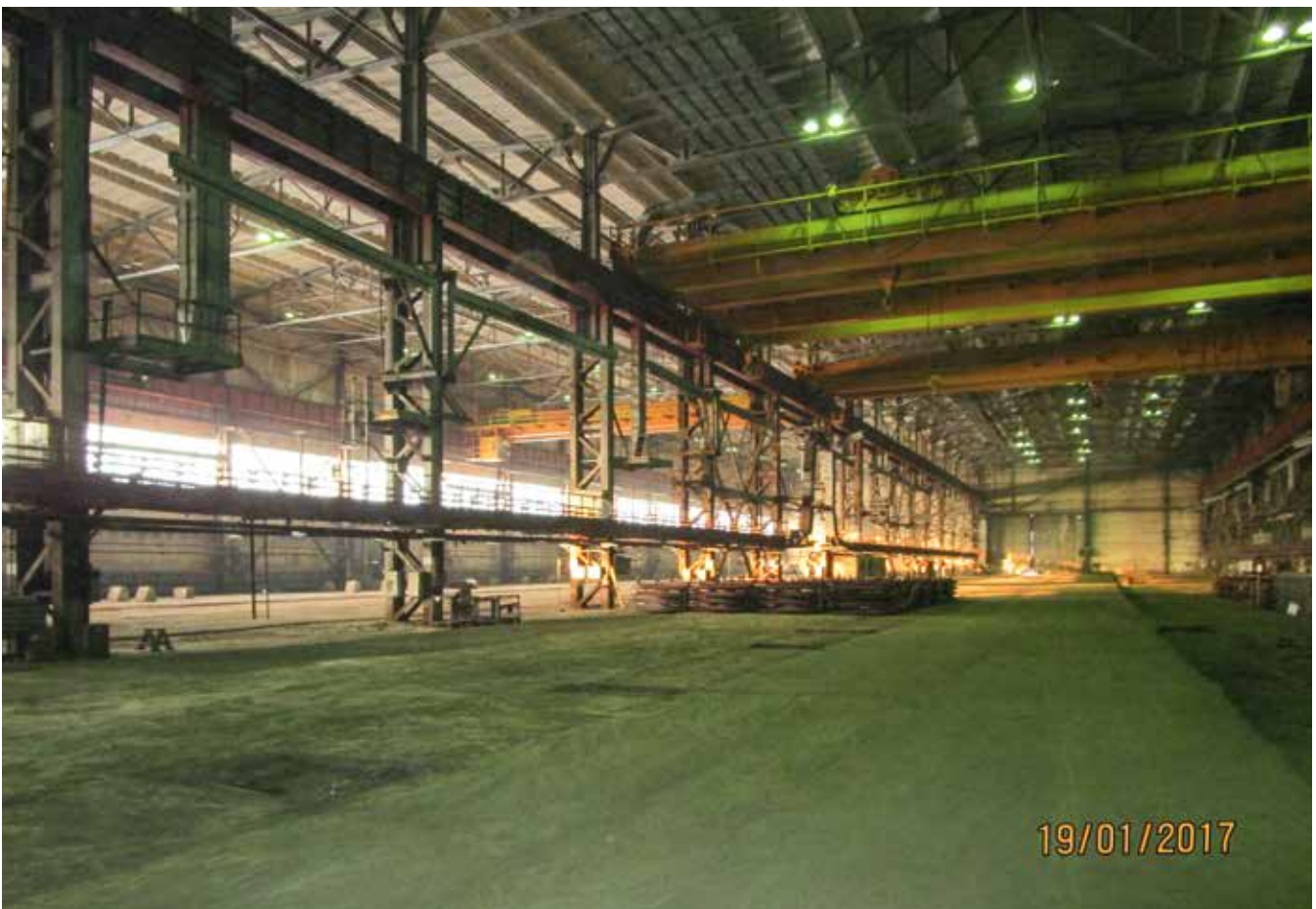
Здание ТМБ площадью 27 648 м 2 с 11 мостовыми кранами
